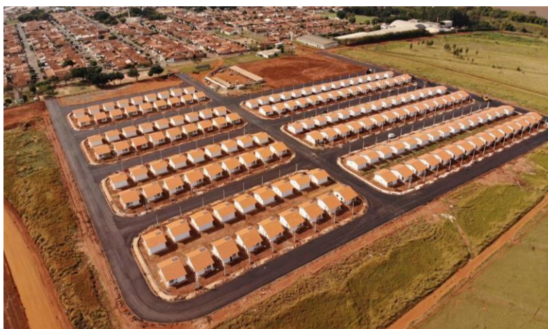
Figura 03: Empreendimento Macatuba (Vista Aérea)
