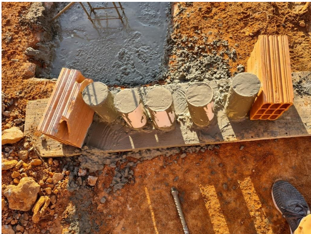
Figura 1 – Corpos de prova de concreto usinado (CDC) moldados no próprio canteiro de obra.
