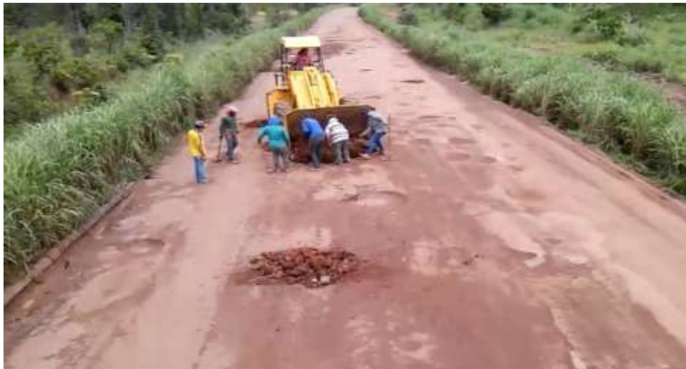
Figura 9 – Cobrimento de buracos em estrada vicinal.
