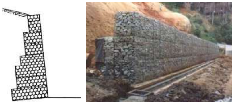
FIGURA 12 – Muro Gabião
