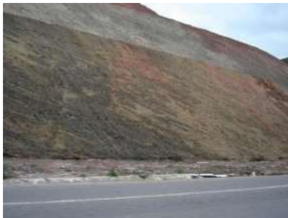
FIGURA 3 – Talude artificial em corte
