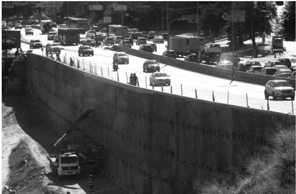
Fig. 4 - Reforços emergenciais sendo realizados na cortina atirantada (website Jornal Otempo, 2014)
