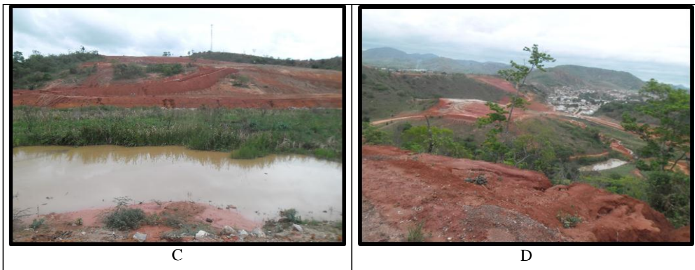
Figura 2: A- Risco Ambiental (assoreamento de nascentes); B- Assoreamento de curso d'água (lagoa); C- Deposição irregular de resíduo sólido na margem de corpo d'água e corte de talude ao fundo; D- Talude sem contenção
