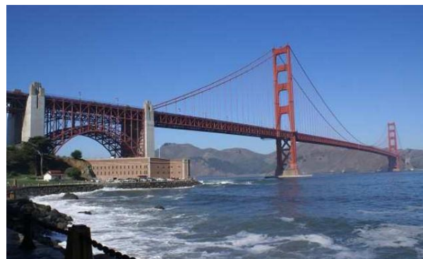
Figura 7 - Ponte Golden Gate
