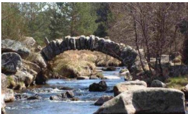
Figura 6 - Ponte em arco de Pedra
