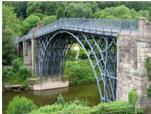
Figura 3 - Ponte sobre o Rio Severn, Inglaterra
