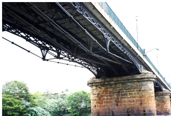
Figura 4 - Ponte sobre o Rio Paraíba do Sul
