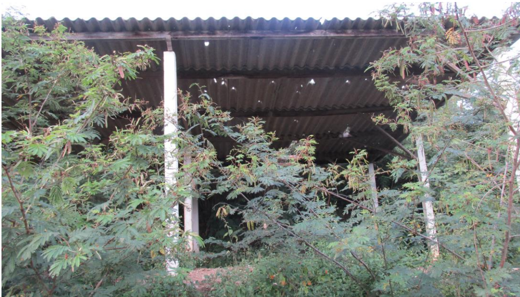
FIGURA 1 – Estado da Usina de Triagem e Compostagem de Carai/MG
