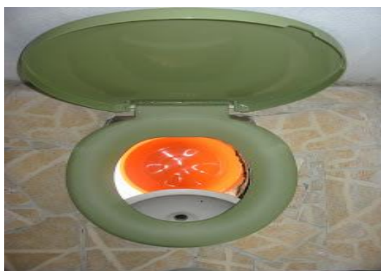
FIGURA 7 – Vaso sanitário segregador de urina
