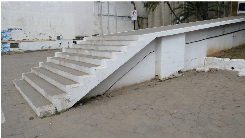
FIGURA 6 - Escada e rampa da entrada principal do Órgão Público
