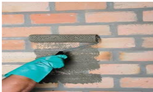
Figura 4: Aplicação do chapisco rolado
