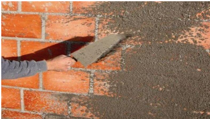
Figura 3: Aplicação chapisco convencional
