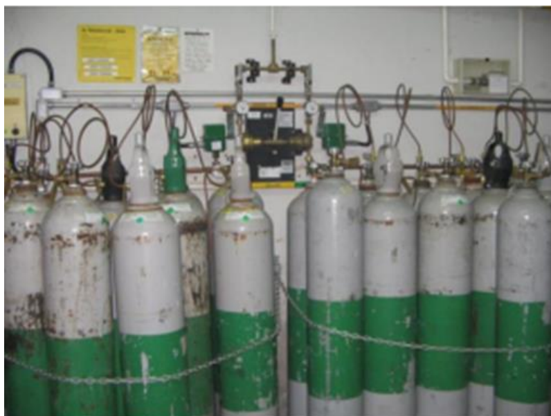
Figura 5. Suprimento reserva de cilindros de ar comprimido medicinal
