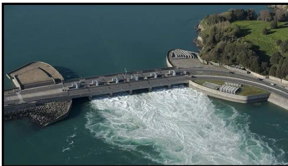
Figura 5. Usina MeyGen, Escócia. Fonte: ENGENHARIA 360° (2022).
