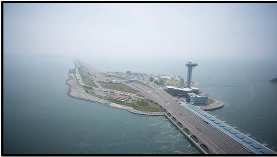
Figura 4. Usina maremotriz de Sihwa Lake, Coreia do Sul. Fonte (POWERMAG, 2015).
