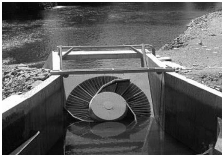
**Figura 7.** Vista do modelo VLH após a sua instalação em Milau, França (MJ2 TECHNOLOGIES, 2010).
