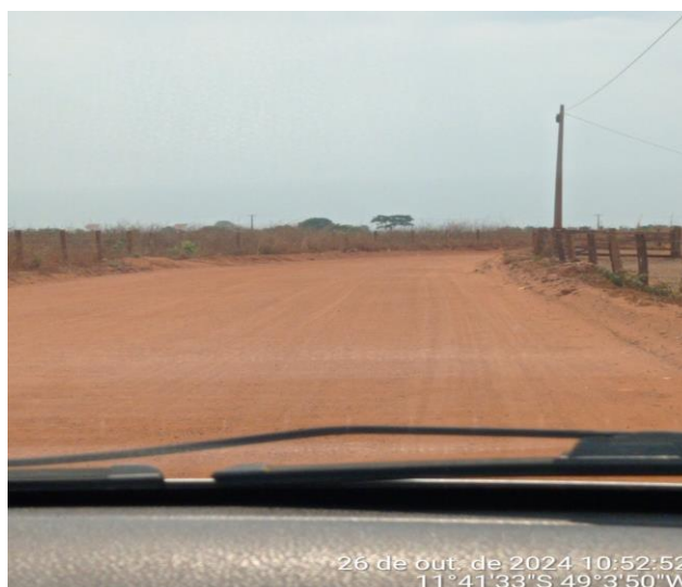
Figura 15: Ausência de sinalização em curva fechada na estrada Avenida Parque, Gurupi-TO.
