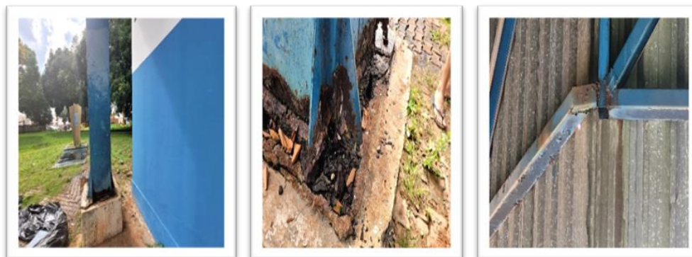
Fotos 13: Estruturas de aço
