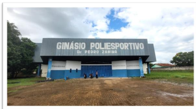
Foto 5 – Vista frontal do edifício
