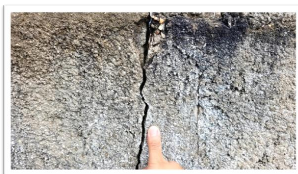
Foto 9: Trincas verticais
