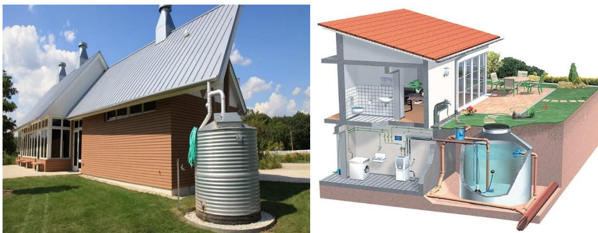
Figura 6. Sistemas de aproveitamento de águas da chuva.
