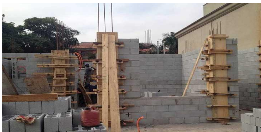
Figura 9 – Sistema construtivo de alvenaria com vedação em concreto
