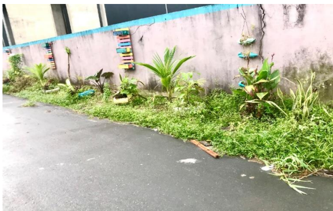
Figura 7 - Local da limpeza sem manutenção, após ação educativa.
