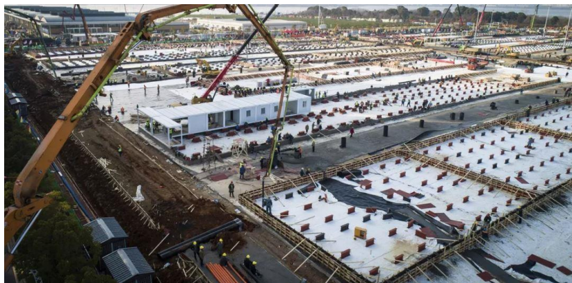
Figura 7 – Hospital de Huoshenshan em desenvolvimento
