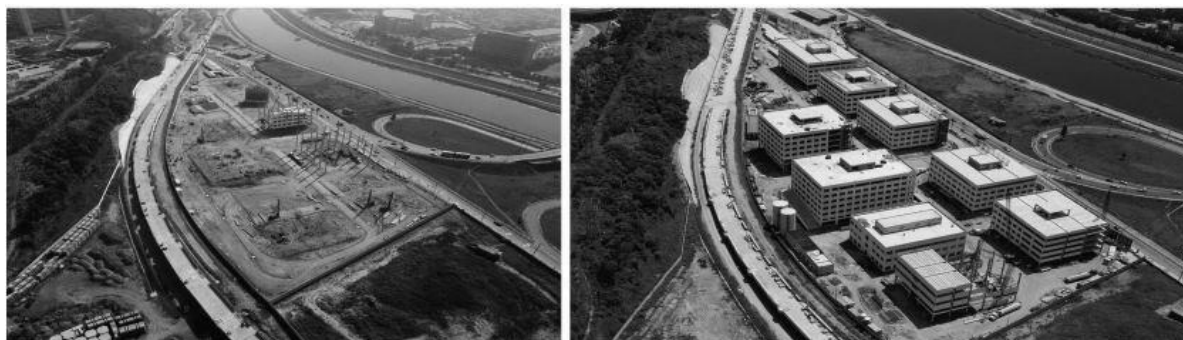
Figura 1 - Fases inicial e final da execução da estrutura do Panamerica Park
